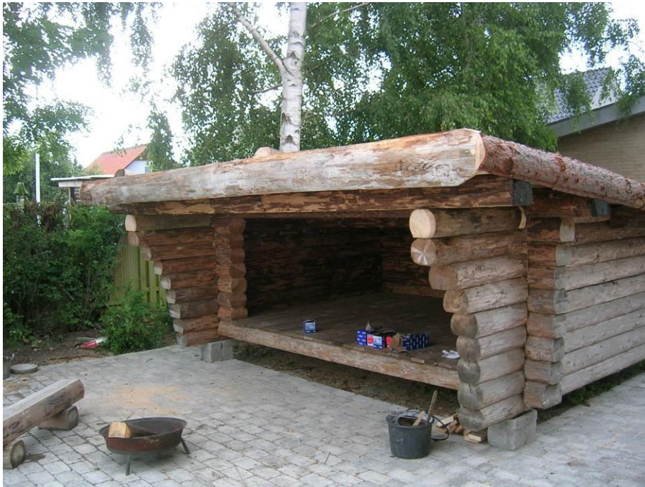
63. Tores shelter set forfra.
