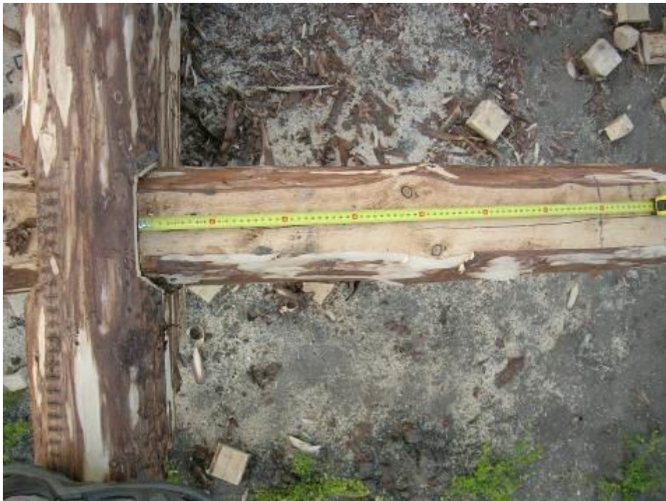
50 Der afsættes et mål på 72 cm. fortil på D-stokkene som vist.
