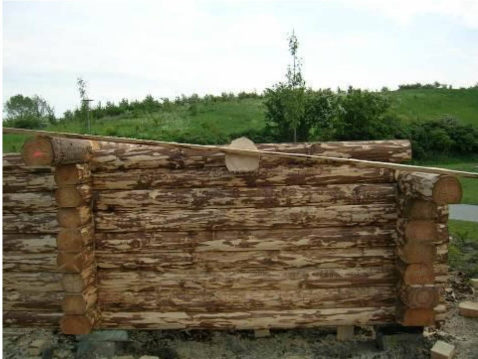
39. Her er retskeden/ et bræt i lagt op fra topåsen til bagåsen for at se hvor meget mellemåsen skal sænkes ned. Taglinien markeres med en streg på mellemåsen
