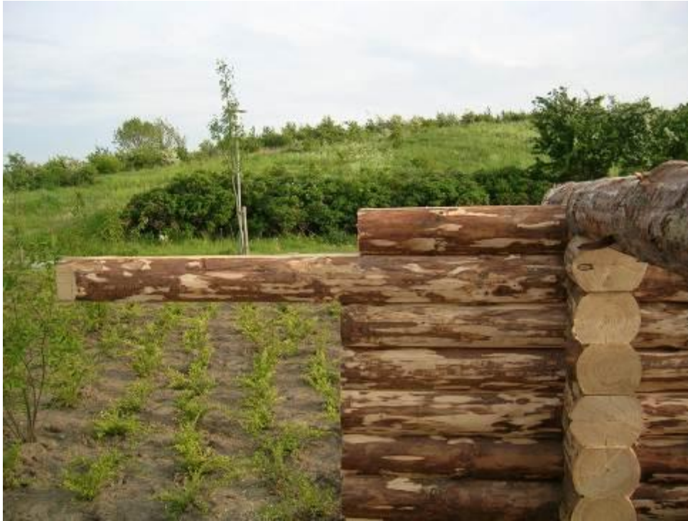
51. Her er D-stokken skåret til. Bemærk at C-stokken under stadig ikke er kortet af. Foråsen skal hvile på C-stokken og støde op til D-stokken.
