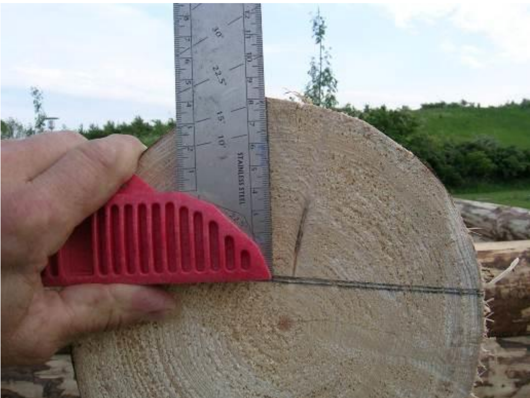
42. Find målet for hvor meget hver ende af mellemåsen skal sænkes ned for at passe til taglinien. I dette tilfælde er det 8 cm MEN vi sænker kun åsen 7,5 for at den være lidt for høj. Dette giver taget et spænd, der gør det stærkere (den romerske bue ). Der kan ind i mellem ske det, at tagbrædderne senere løftes op, men det forsvinder når der lægger jord på taget.
