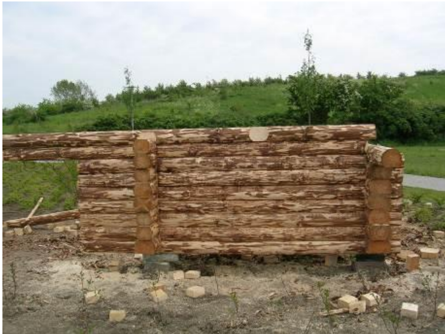
33. Her er D-stokkenlagt op. Den knude der ses i midten af den, viser hvor mellemåsen skal placeres. Selve knuden skal skæres af, hvilket godt kan gøres inden D-stokken er lagt op.
