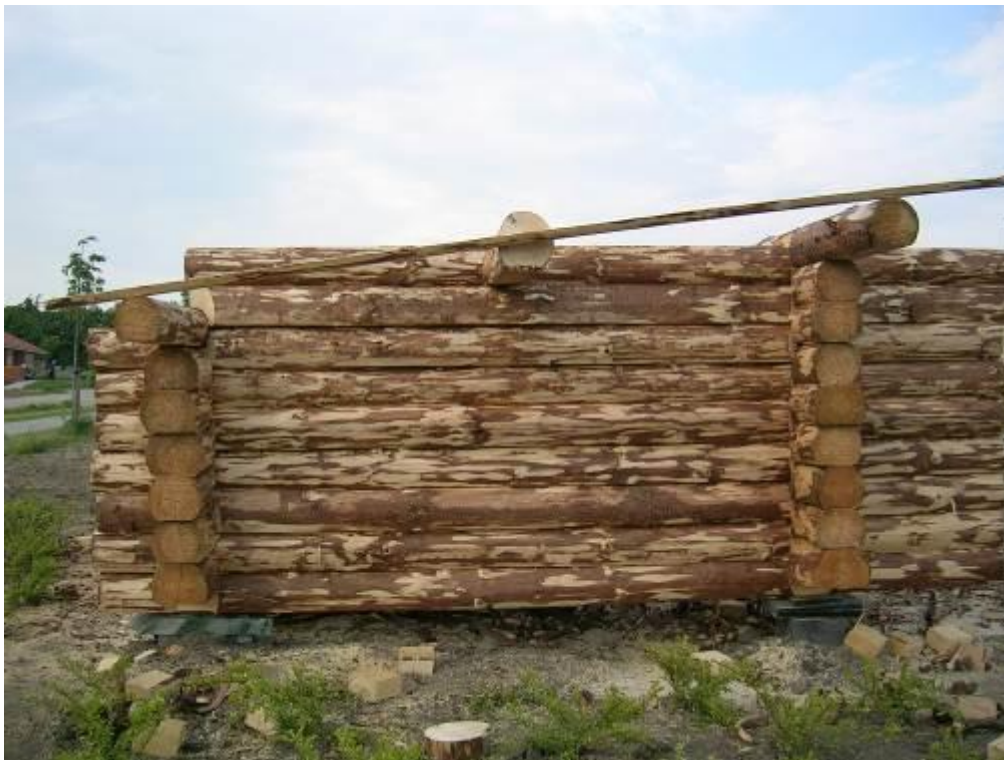
40. Det samme gøres i hver ende af shelteret, da åsenes form er konisk (rod og top).
