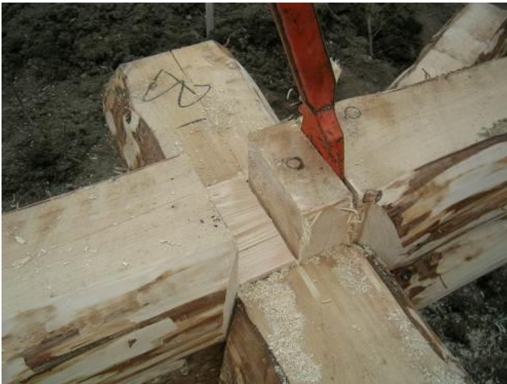
17. Jernet stikkes kun lidt ned, så er det lettest at brække træet.
