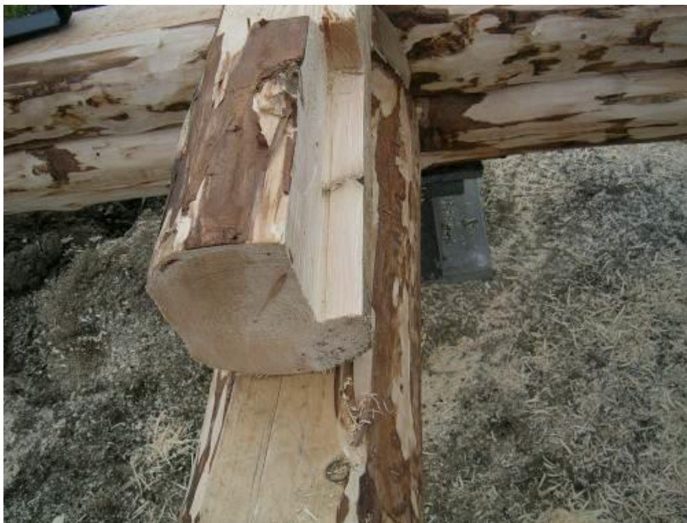
25. Der skal også skæres riller i de to små nederste forstykker. Tjek at rillerne skæres på de rigtige sider,- mange har skåret dette forkert.
