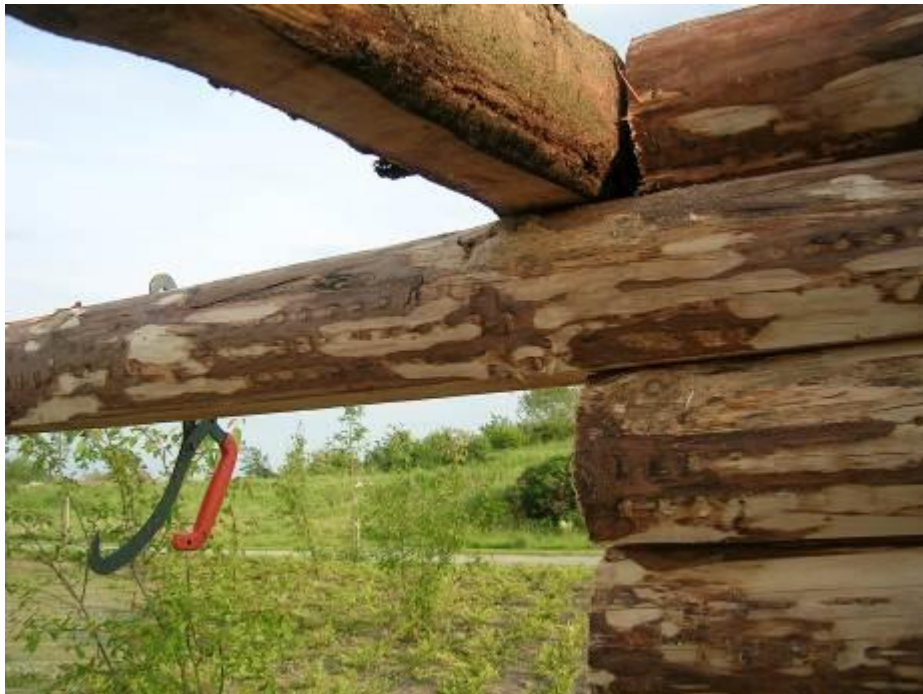
52. Her er foråsen lagt op. Foråsen kan lægges på TO måder. Den letteste måde er at lægge den flade side nedad.
