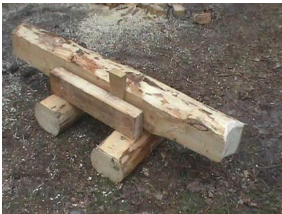
57. Her ses stokken i en simpel form, så den er klar til skæring. Dette foto er fra en tidligere byggemåde og derfor er stokken rundet til i enden.
