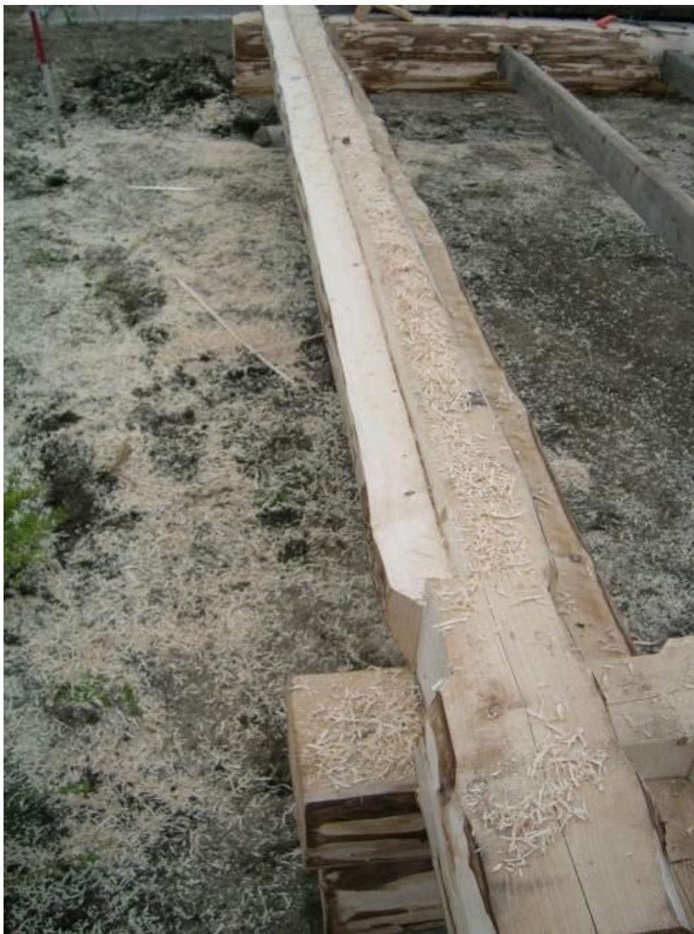
23. Her er rillen skåret og stokken ligger stadig med undersiden opad. Husk at rillen kun skal skæres på den del af stokken, der er INDE i shelteret.
