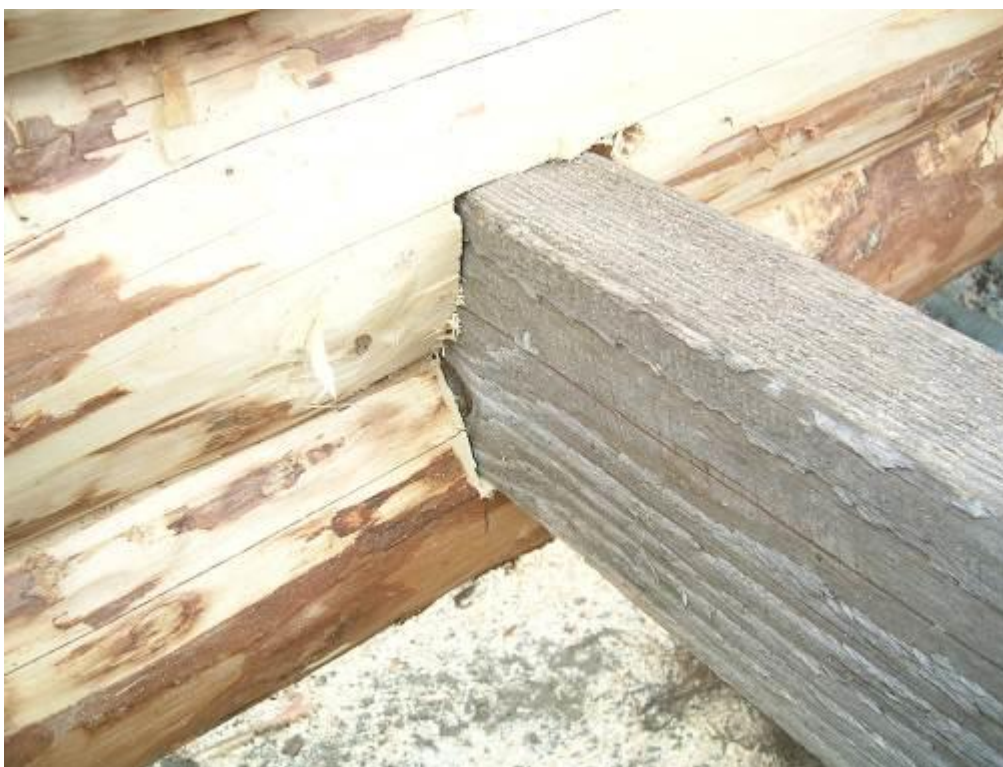
13 2. lag er lagt på plads. Vi er under gulvet endnu og evt. fejl ses ikke.
