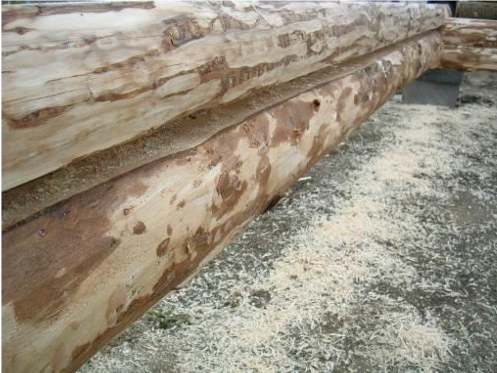
24. Stokken med rillen er lagt på plads. Gulvbrædderne hviler på den nederste stok og skjules af rillen. Det er derfor meget let at lægge gulvet og få et pænt resultat.
