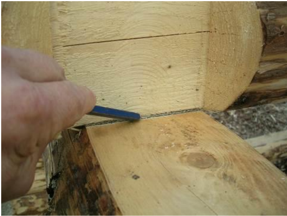
43. Kanten af mellemåsen mærkes på stokken i gavlen.
