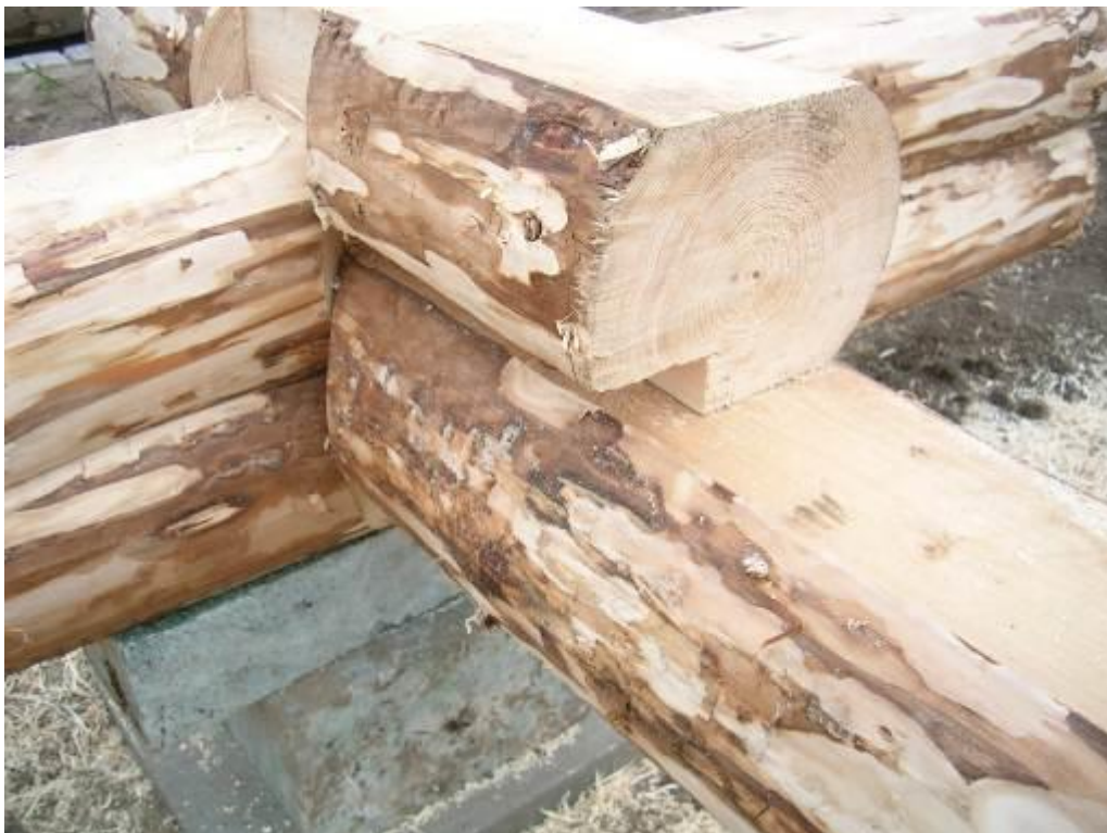
27. Rillen i det højre forstykke.
