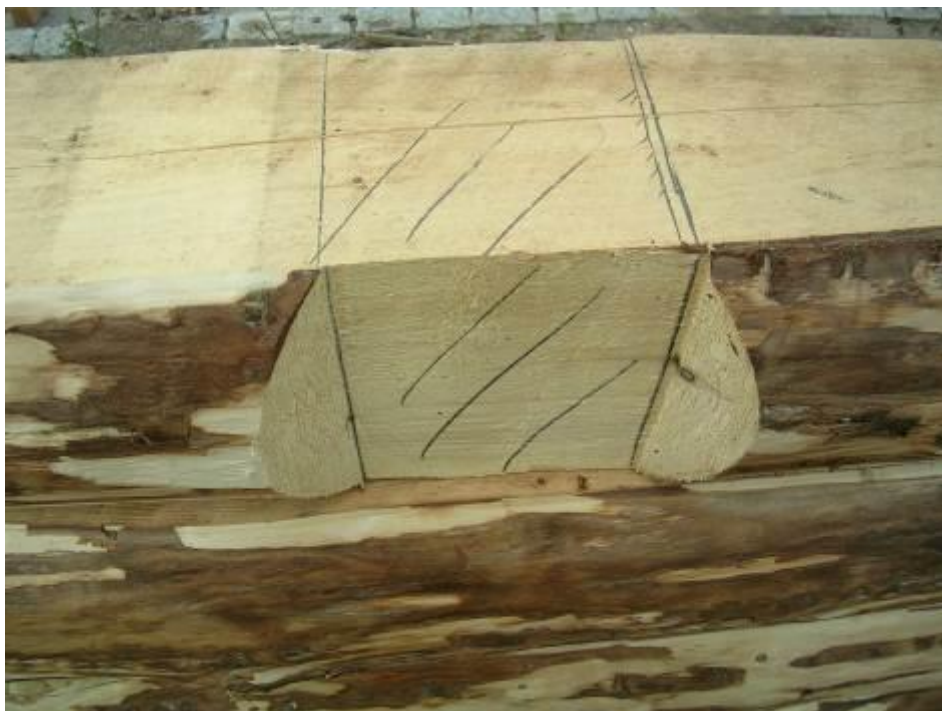
34. Den midterste del af knuden, der skal skæres væk.
