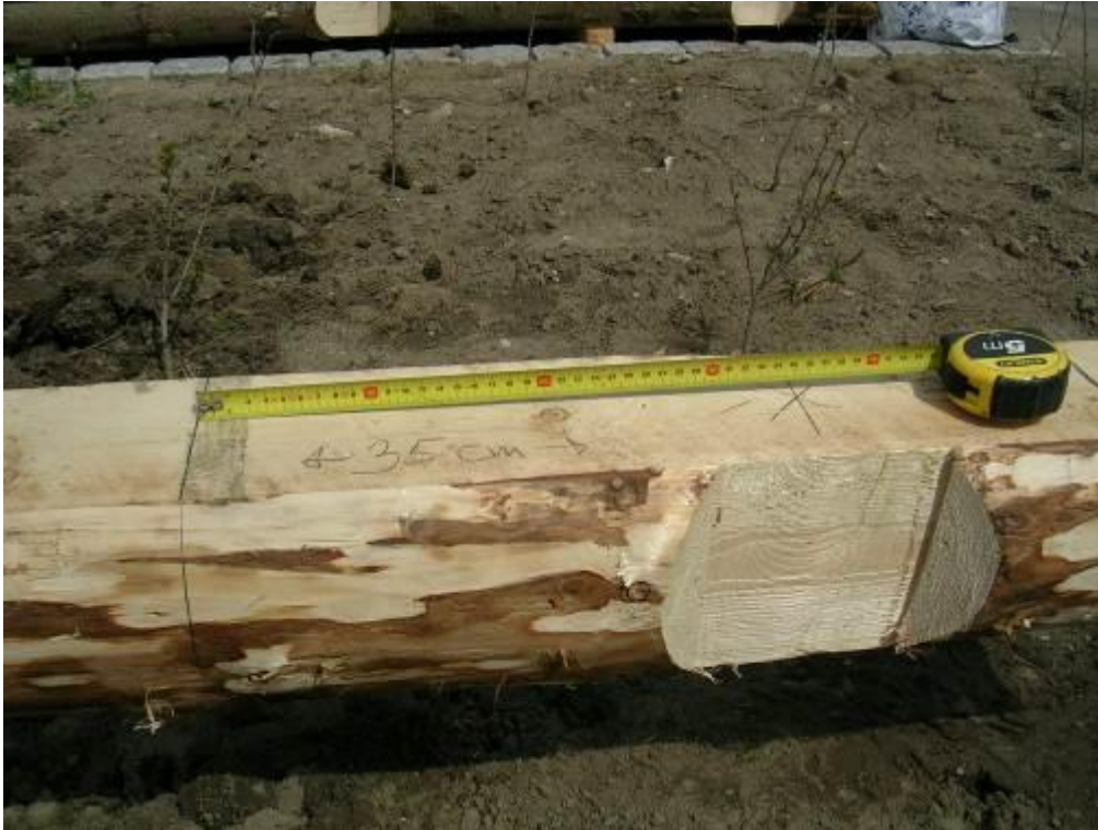
8. De små forstykker skæres af. Dette gøres i en fast afstand på 35 cm fra knudens center.
