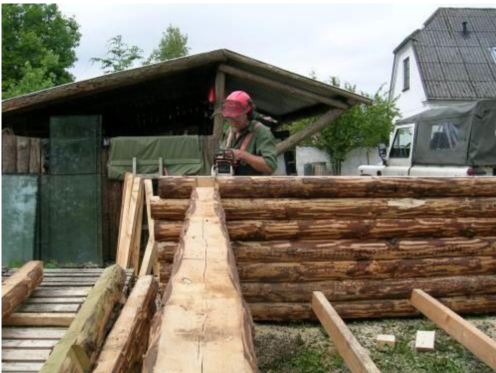
29. Den anden ende shelteret. Bemærk gulvstrøerne i gavlene.
