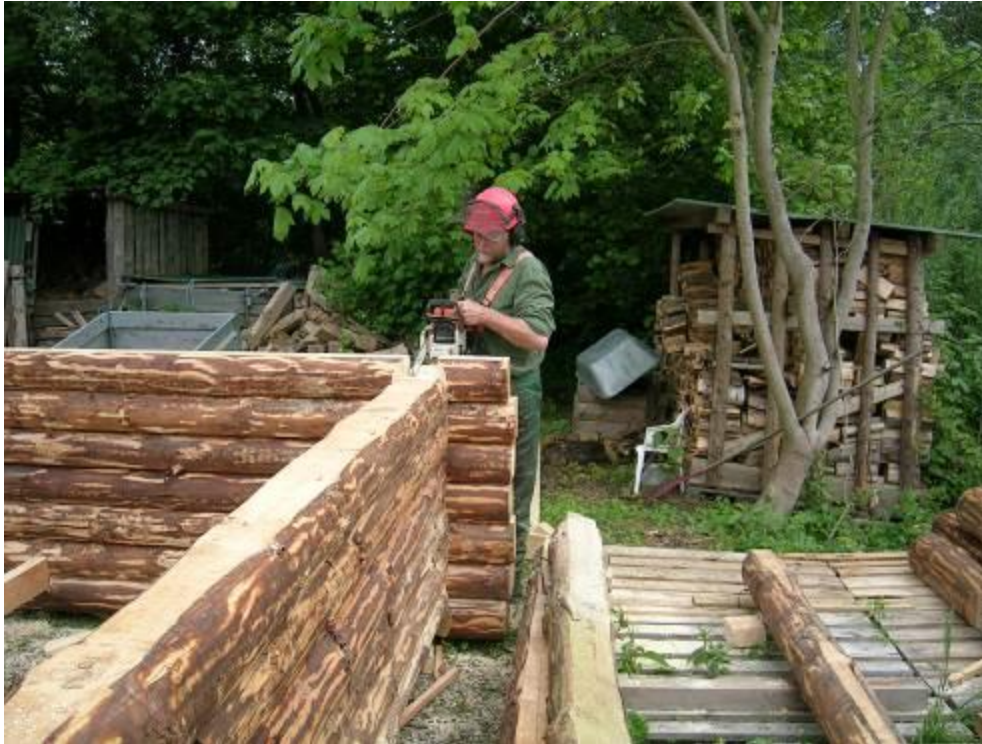
28. Bagvæggen er oppe. Her er det en andet shelter, som jeg bygger på Godthåb Mølle. Det skal senere tages ned igen og sættes op igen et andet sted. Alle stokkene bliver derfor nummererede.
