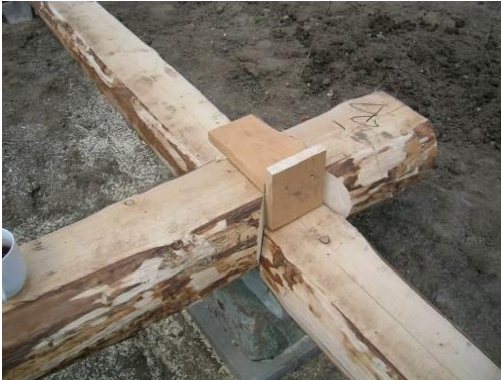
14. Koen er lagt på plads til opstregning til næste udskæring.
