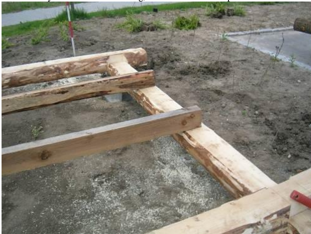
9. Her er gulvstrøerne lagt ud, hvor de skal lægges. Mærk op med en blyant omkring dem.
