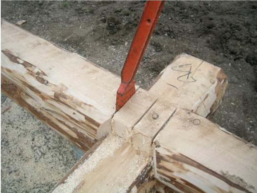
16. Knuden brækkes ud med et fældejern eller et brækjern.
